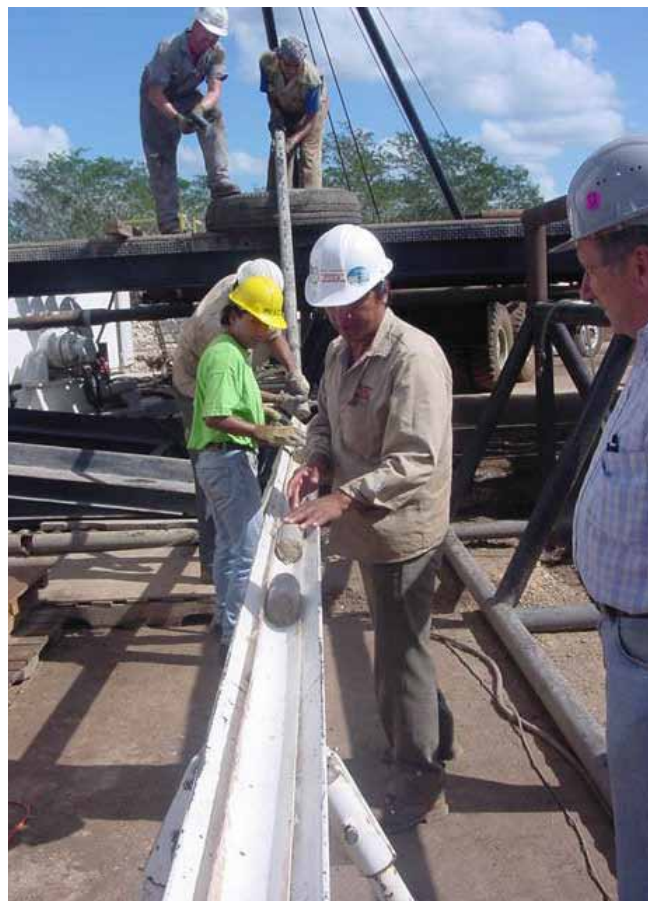
Fig. 4 Recuperación de núcleos en el programa de perforaciones científicas Chicxulub. Los proyectos de perforación en el cráter han incluido programas de recuperación continua de núcleos
