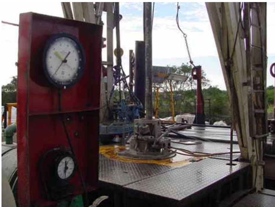
● Fig. 2 Plataforma de perforación del Proyecto de Perforaciones Científicas Chicxulub- Pozo exploratorio Yaxcopoil-1
